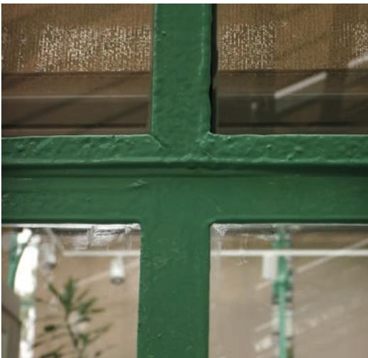
**Abb. 11** Detail der Stahlkonstruktion, oben der historische, unten der erneuerte Stahl – Aufnahme © CHRISTIAN BERG 29.09.2020.
