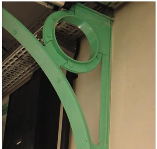
**Abb. 13** Detail der Stahlkonstruktion mit eingeschraubten Verstärkungselementen – Aufnahme © CHRISTIAN BERG 26.09.2020.
