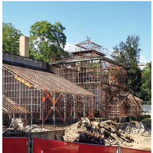
**Abb. 9** Die Stahlkonstruktion wird aufgebockt
