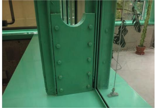
**Abb. 12** Detail der Stahlkonstruktion mit eingeschraubten Verstärkungselement – Aufnahme © CHRISTIAN BERG 29.09.2020.
