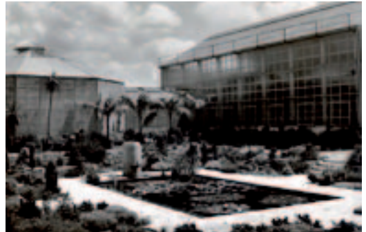
Abb. 2 Blick auf das Victoria-Regia-Haus und Palmenhaus von Westen im Jahr 1939. Im Vordergrund der alte Wassergarten.
